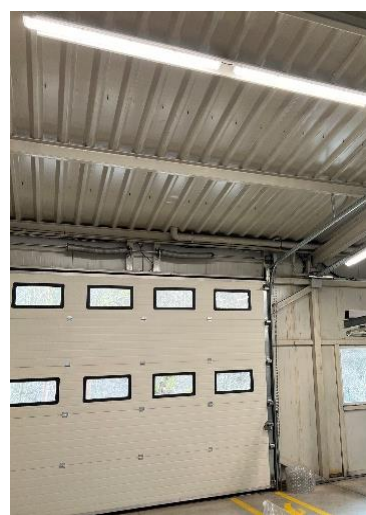
Старо конвенционално осветление в производствените помещения
