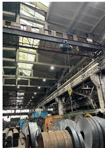
Старо конвенционално осветление в производствените помещения
