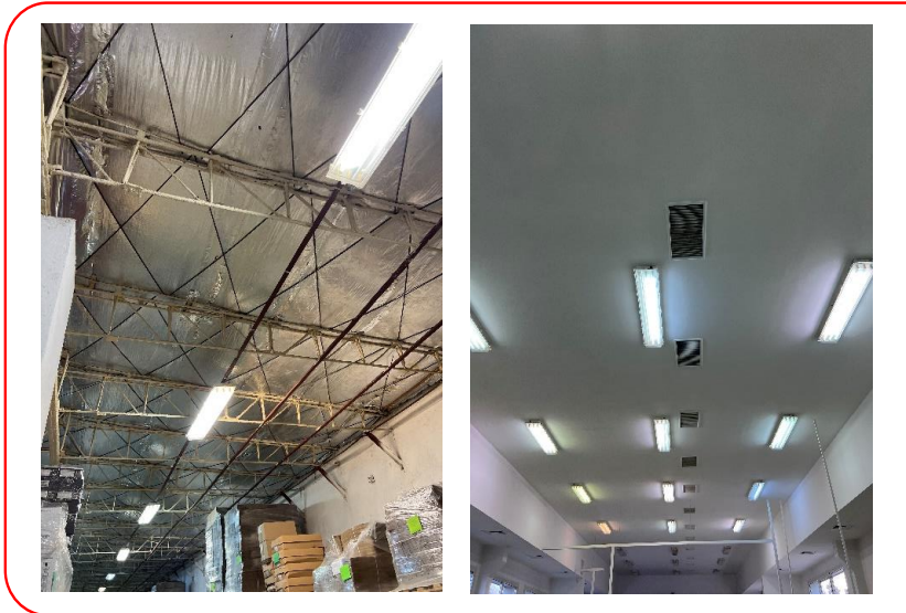
Старо конвенционално осветление в производствените помещения
