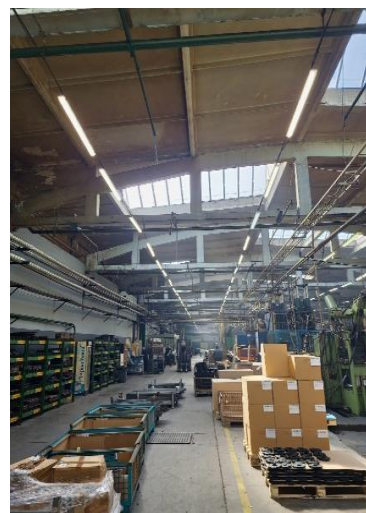
Старо конвенционално осветление в производствените помещения
