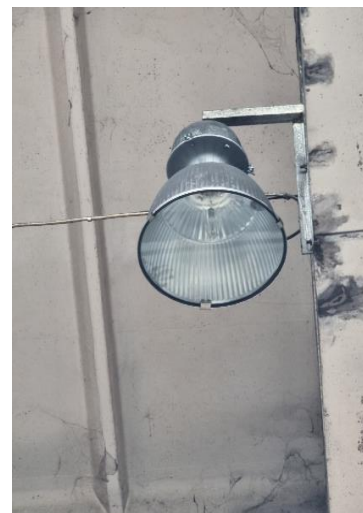
Старо конвенционално осветление в производствените помещения
