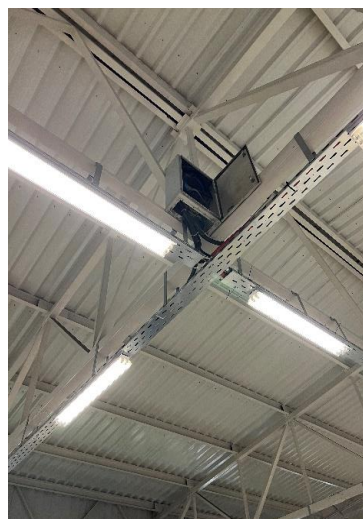
Старо конвенционално осветление в производствените помещения
